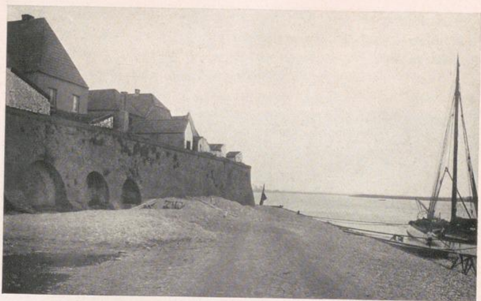
3. Jons am Niederrhein: Uferseite.
