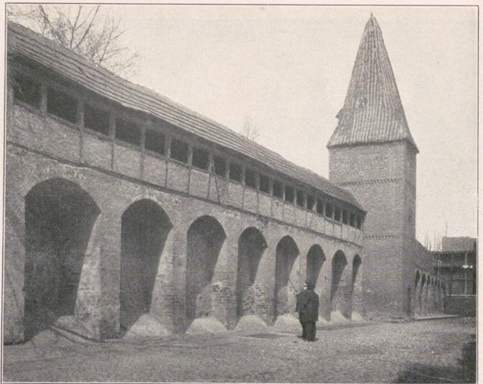
64. Zerbst: Stadtmauer mit Wehrgang
