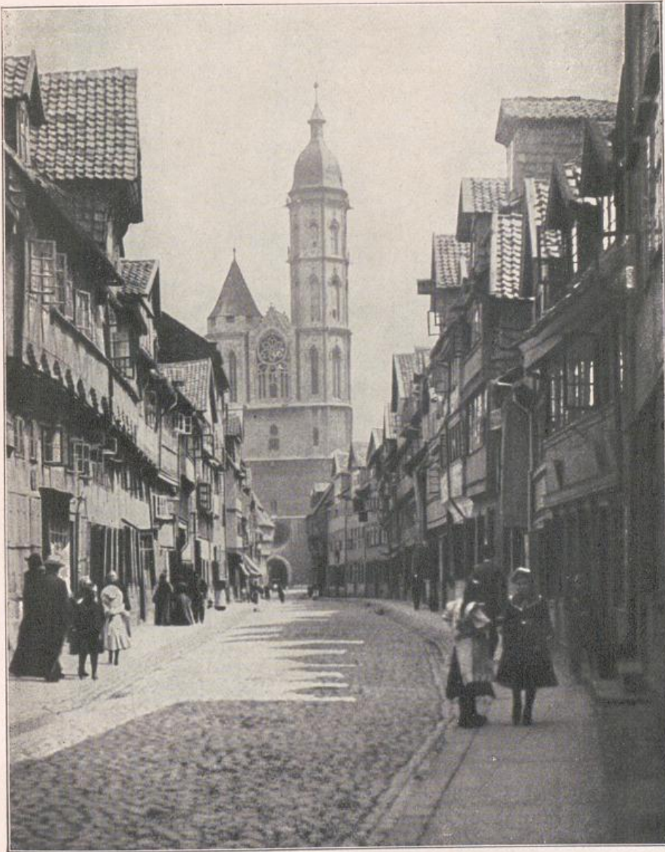
116. Braunschweig, Neustadt: Weberstraße, Andreaskirche
