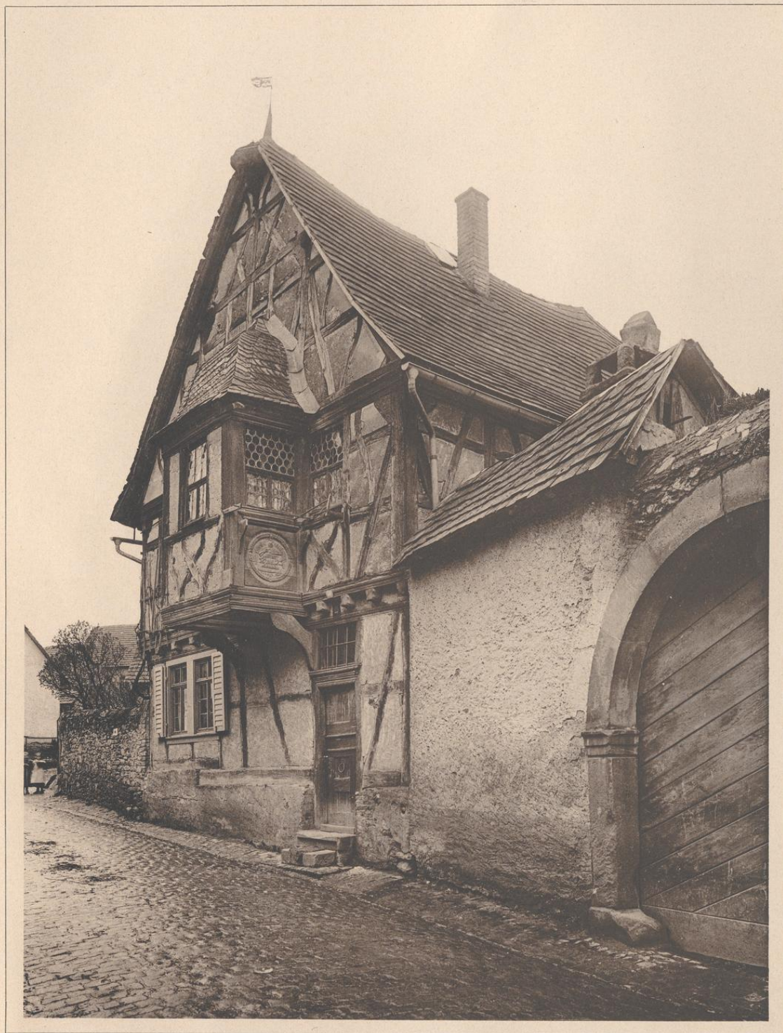
HAUS IN KIEDRICH BEI WIESBADEN. 1672.
